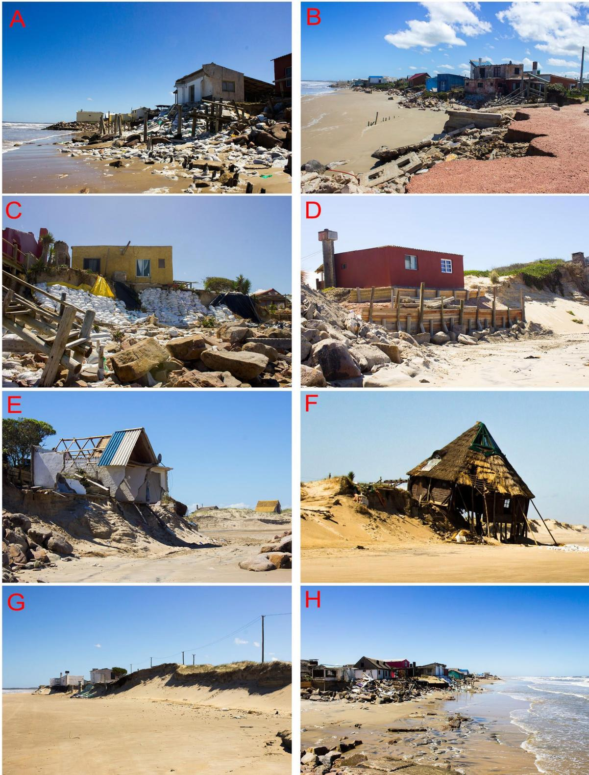
*FIGURA 4: Erosão costeira em Aguas Dulces (Novembro de 2016): proteção com sacos de areia e postes de madeira (A), muros de concreto (B), lona e enrocamento (C), muros de madeira (D); escarpas erosivas em dunas (E, F e G); presença de minerais pesados e entulhos no pós-praia (H).*
